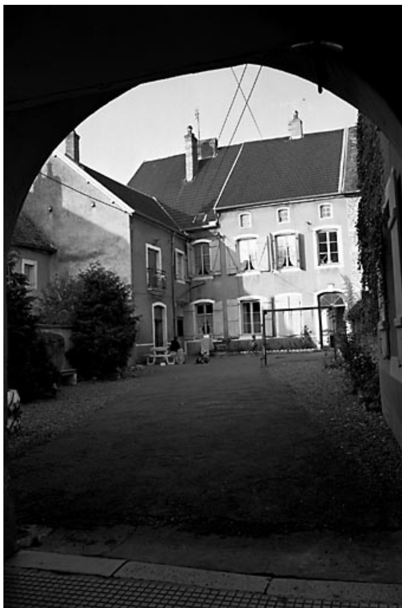
Façade antérieure sur cour.
