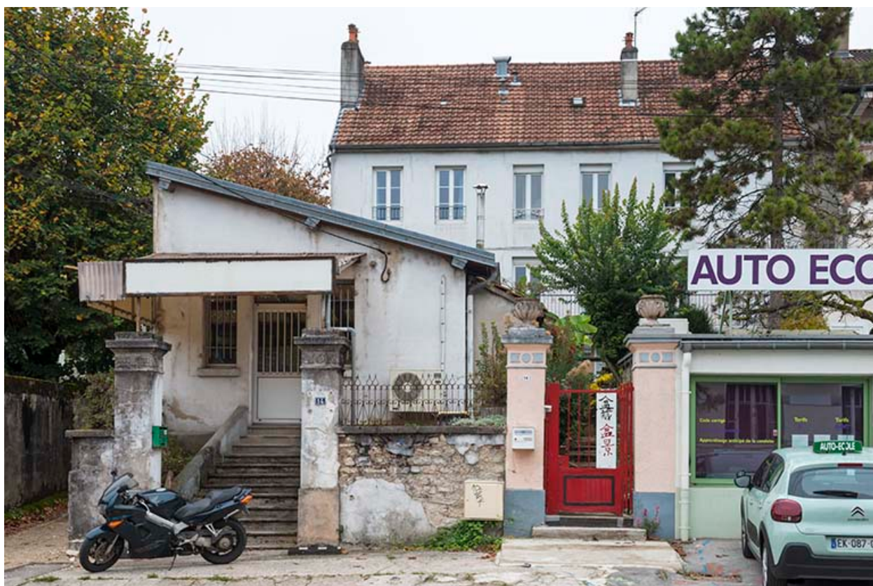
Vue d'ensemble depuis l'avenue.
