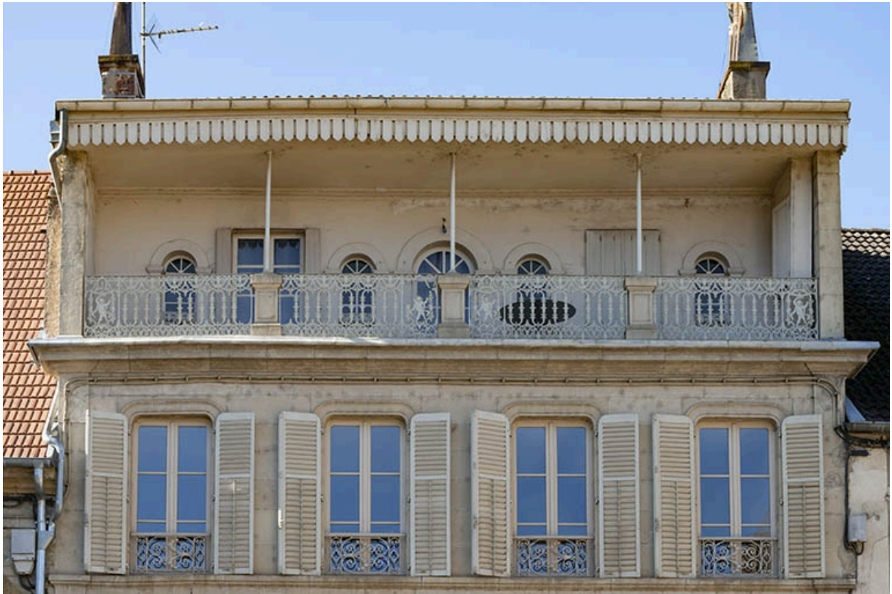
Détail des deux derniers niveaux.
