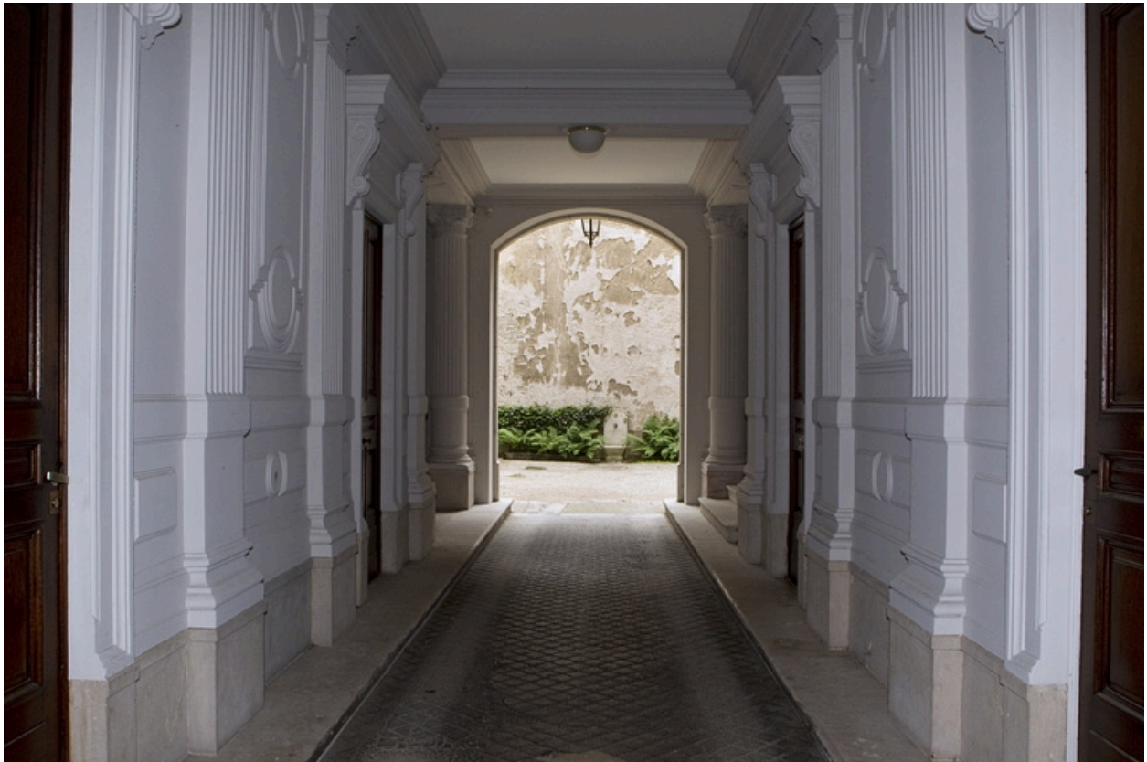
Passage cochers :vue d'ensemble depuis la cour.
