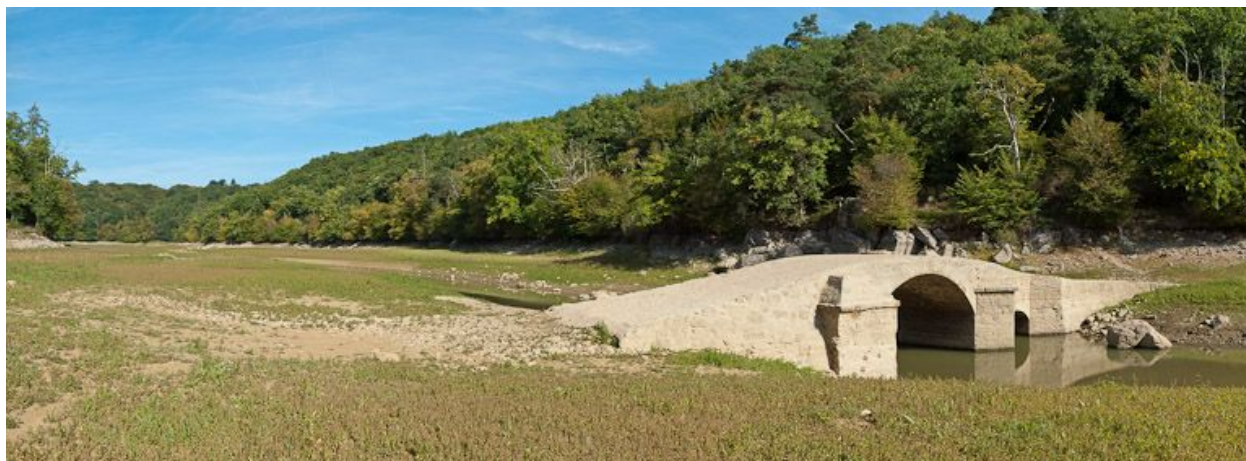
Vue du pont.
