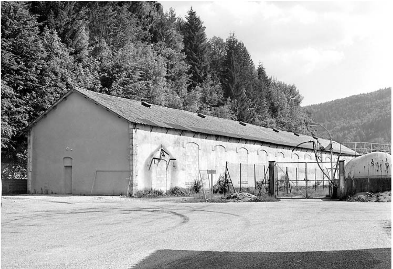
Remise ferroviaire, depuis le nord.
