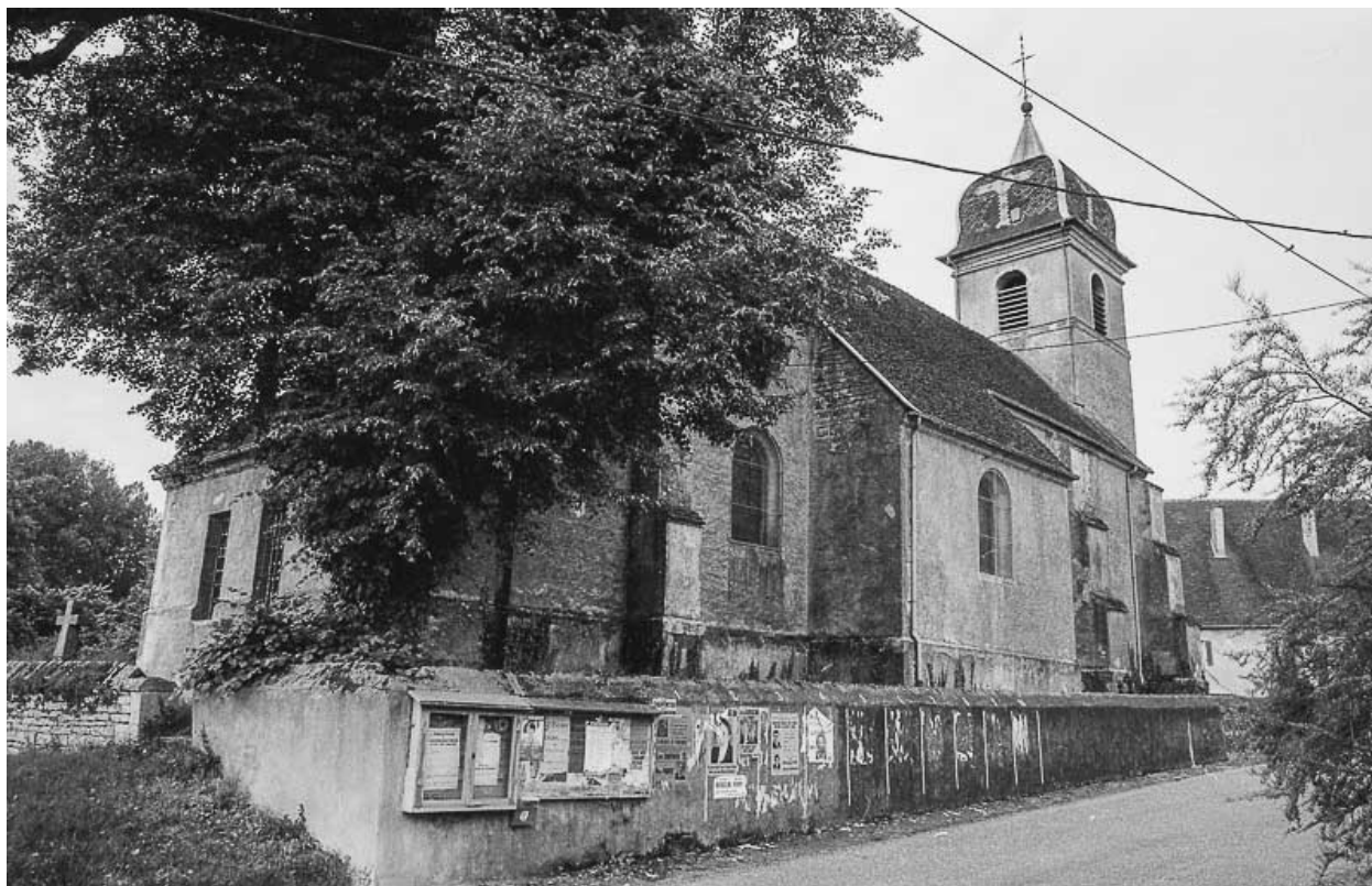
Façades latérale gauche et postérieure.
