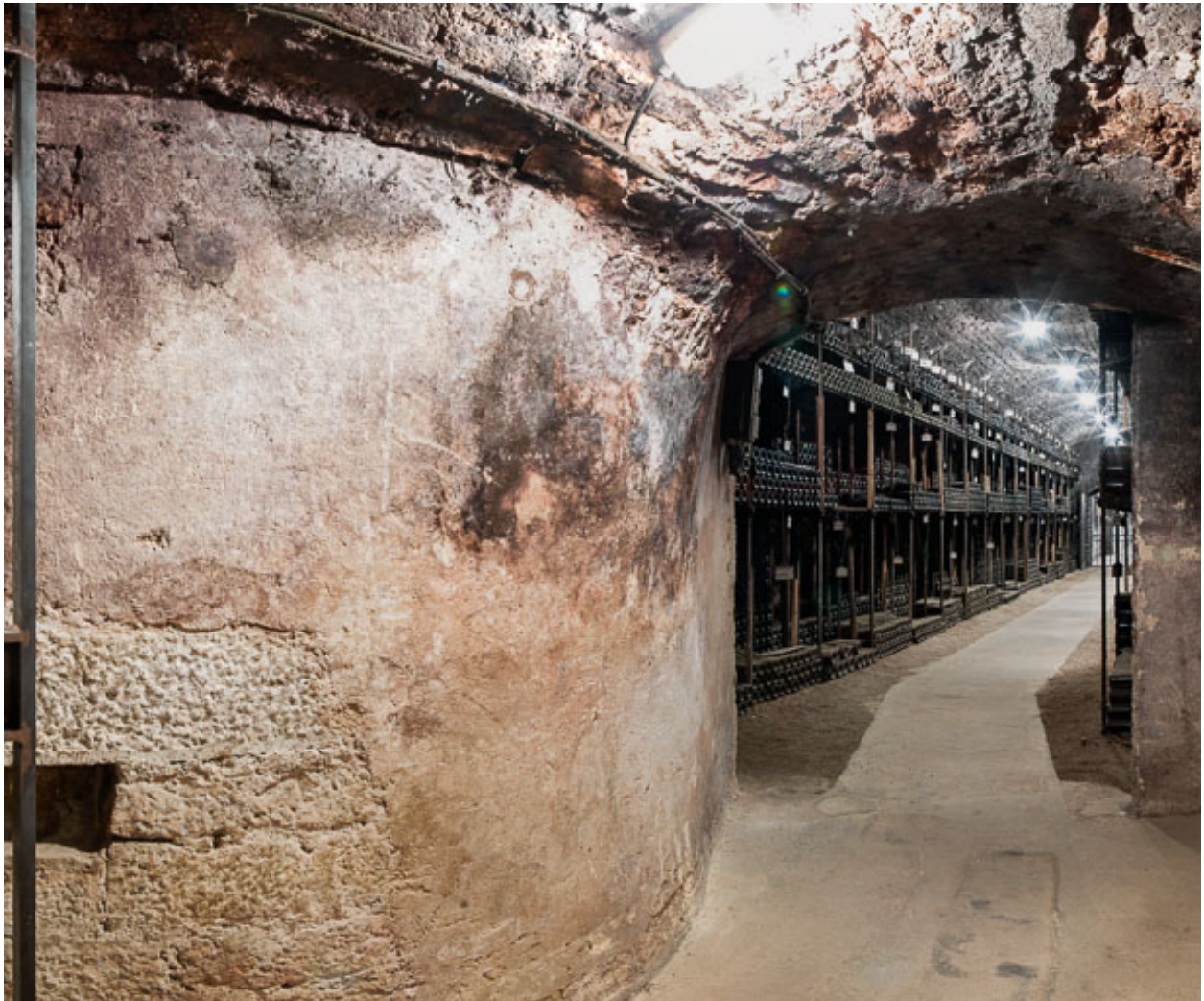
Cave de vieillissement, le long de l'ancien rempart (1er sous-sol) : au premier plan, fondations de la tour nord-ouest..
