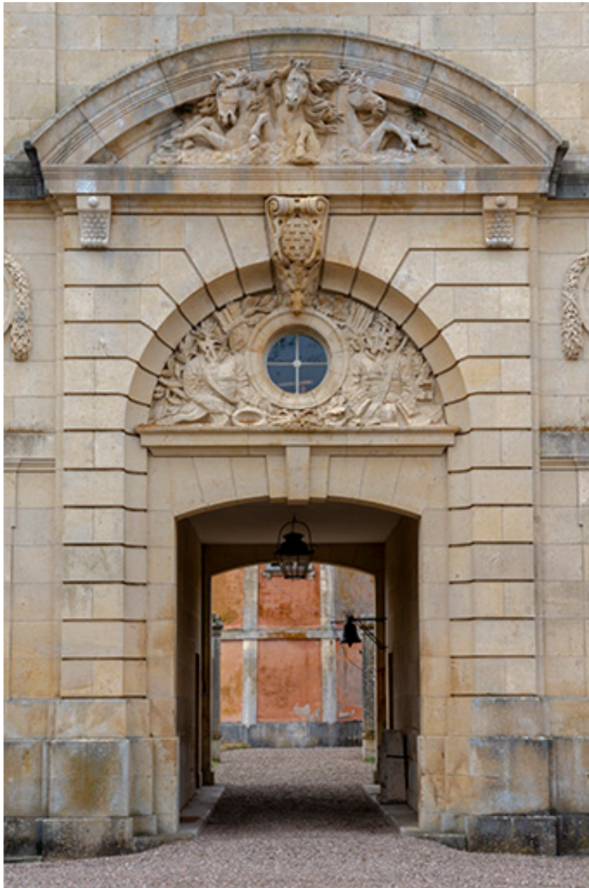
Portail à porte cochère du pavillon central.
