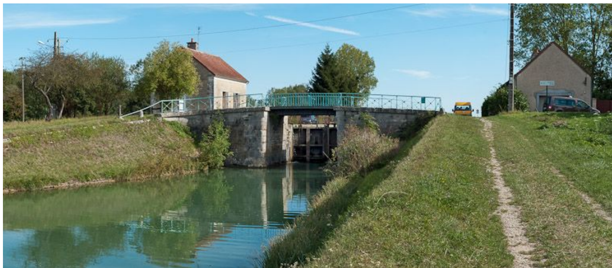
Le pont de l'aval.
