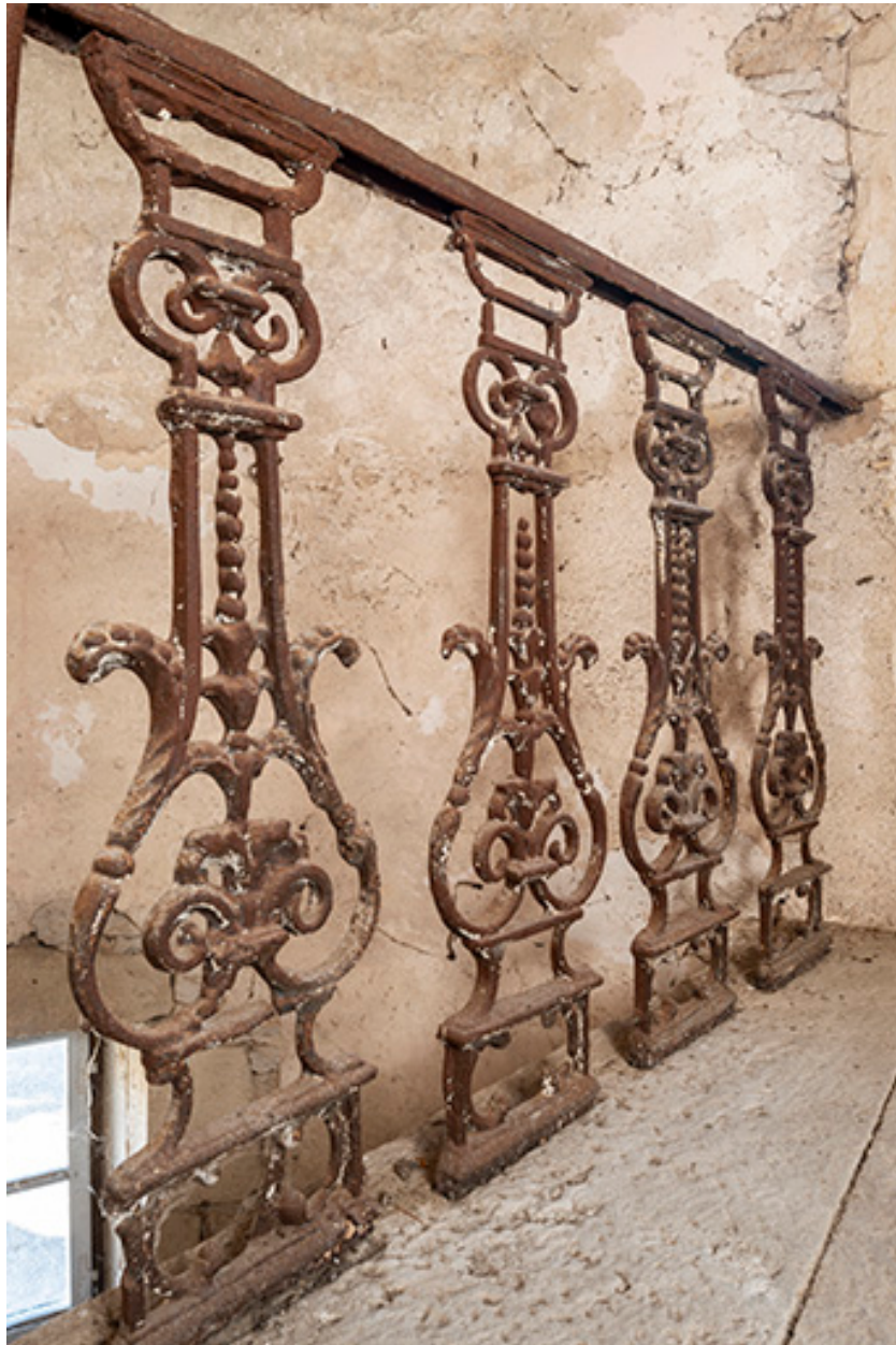
Garde-corps à motif de balustres en ferronnerie.
