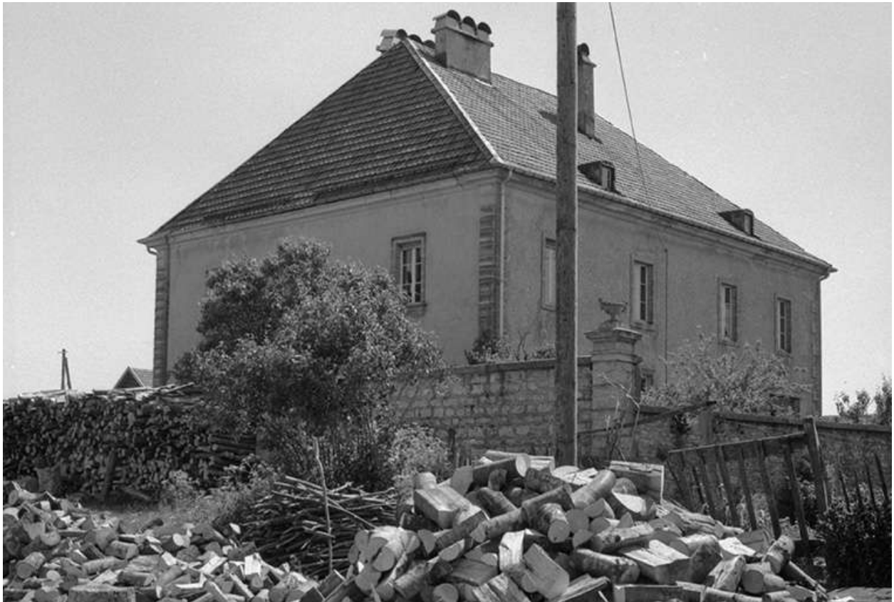
Façades postérieure et latérale gauche.
