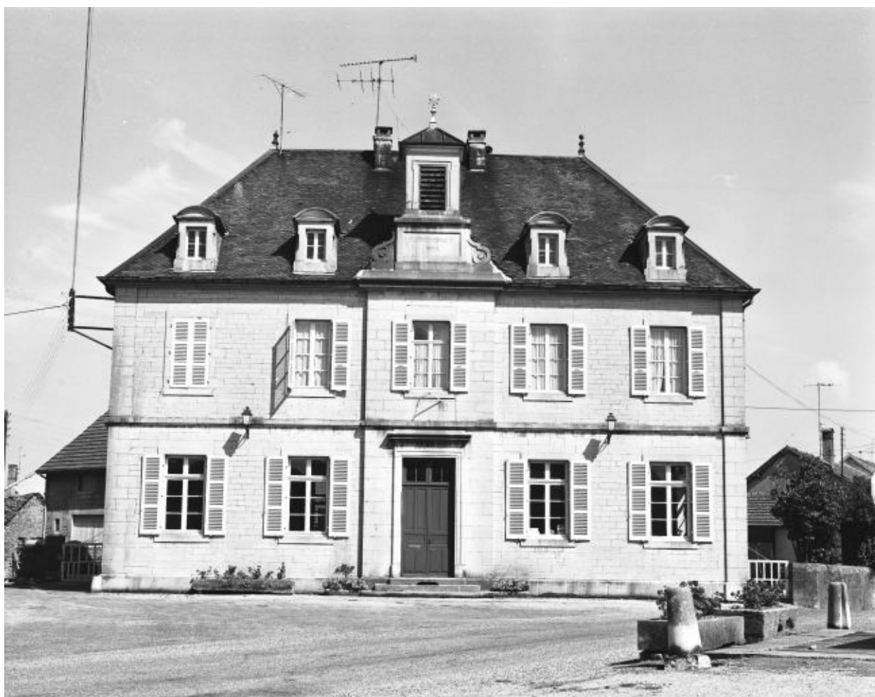
Façade antérieure : vue rapprochée.
