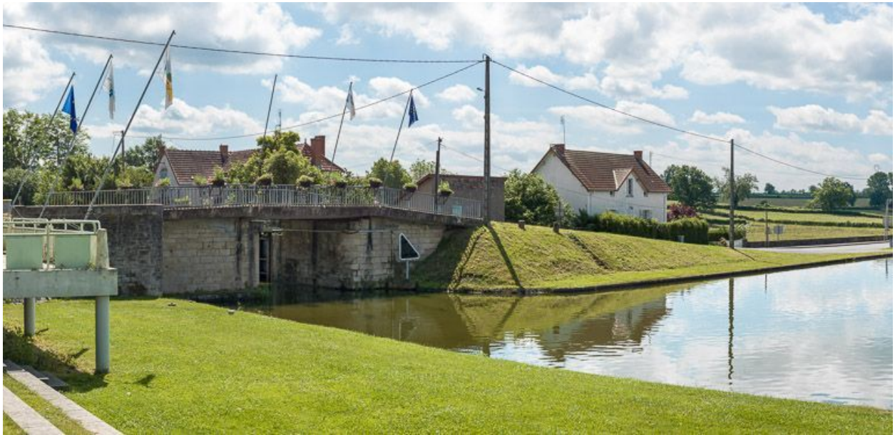
Le pont, vu d'aval.
