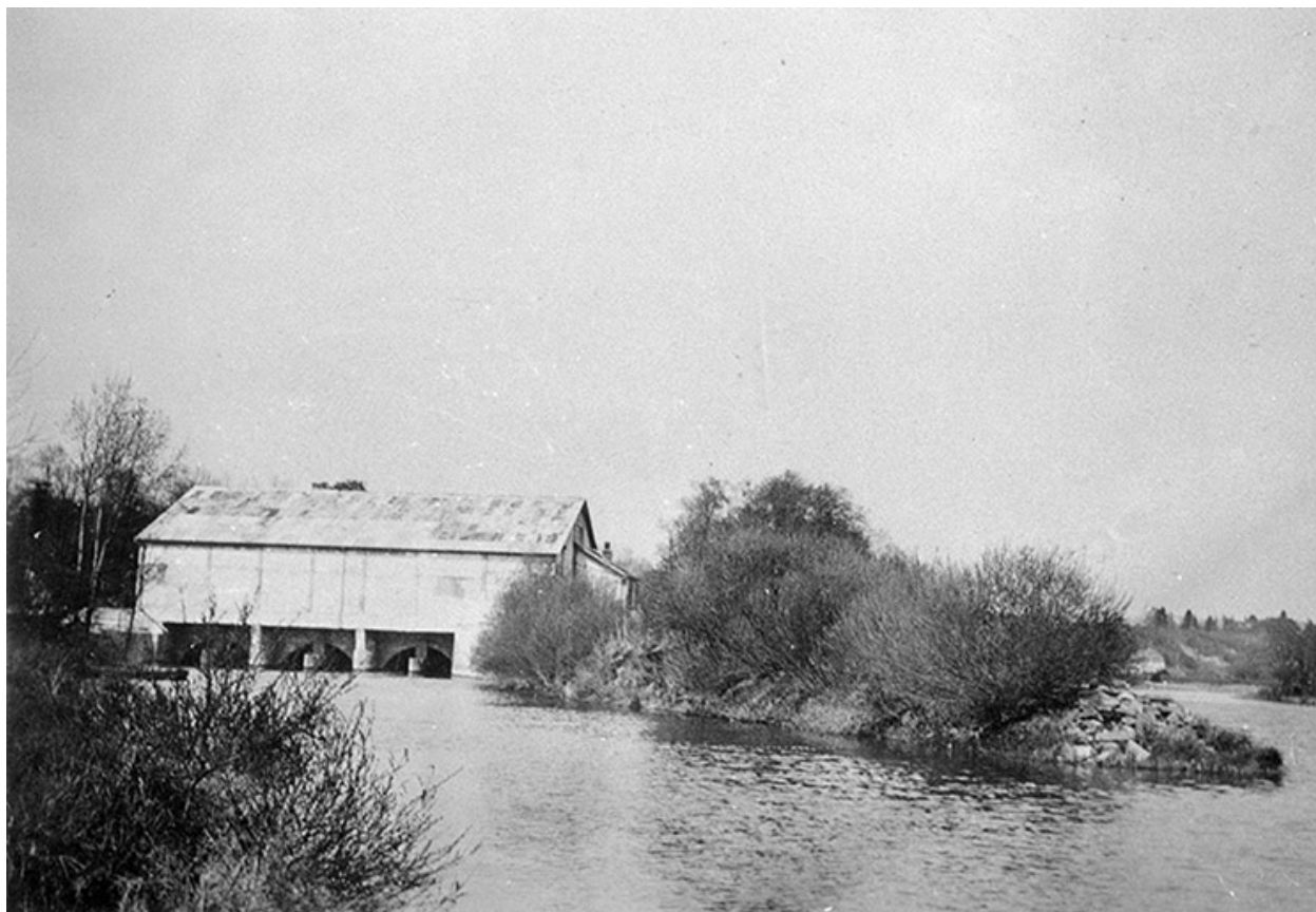
Station. Canal de fuite.
