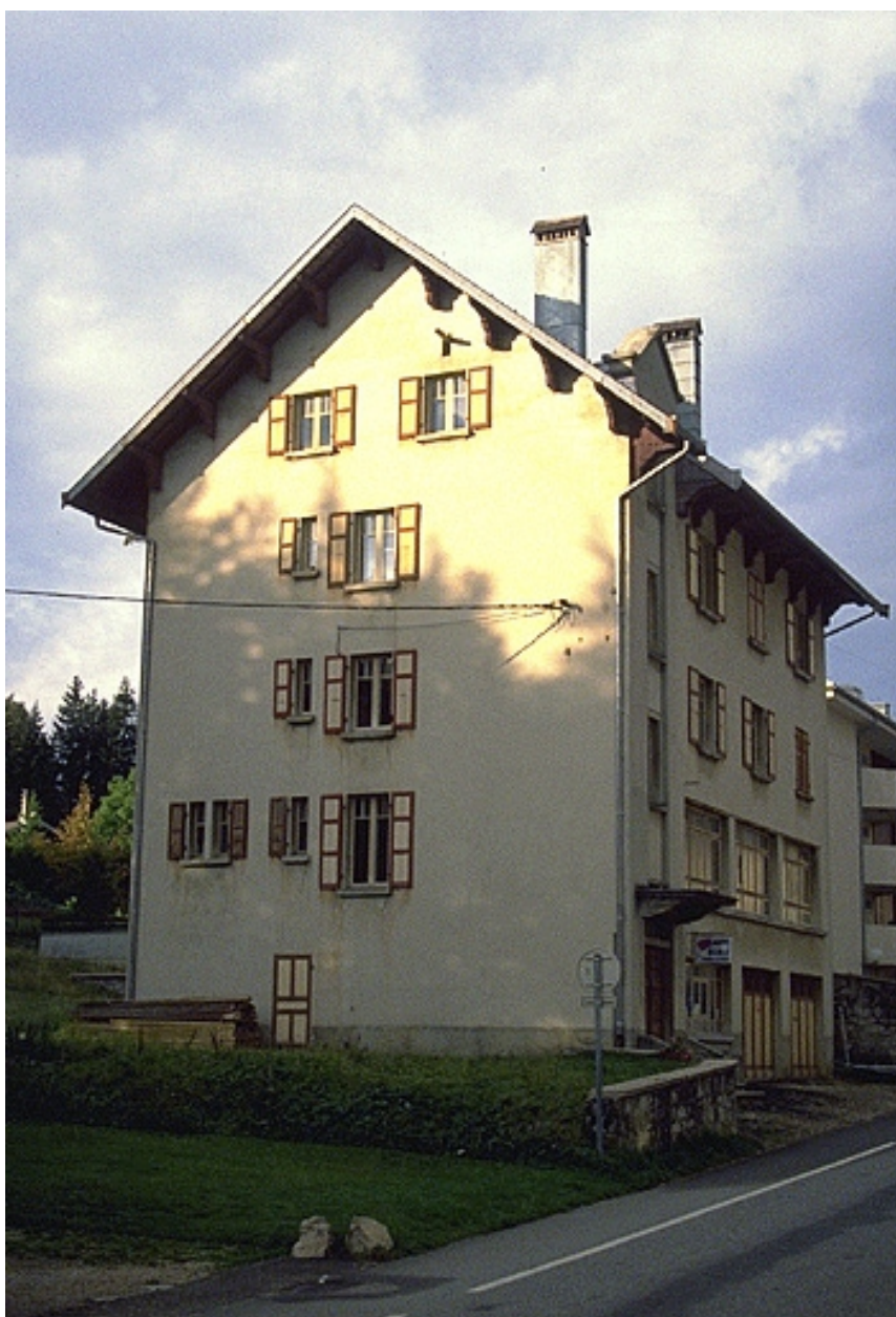
Façades antérieure et latérale gauche.
