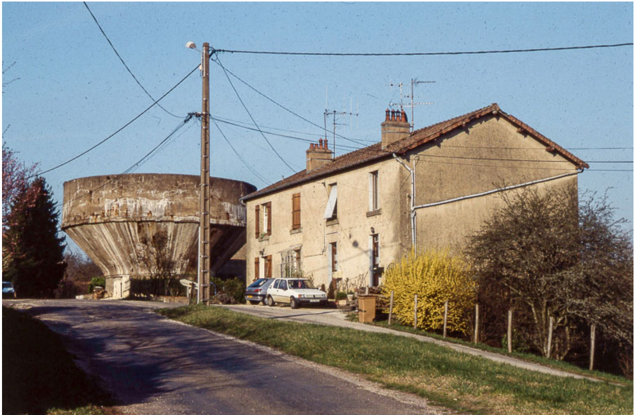
Réservoir industriel (saumure) et logement d'ouvriers.
