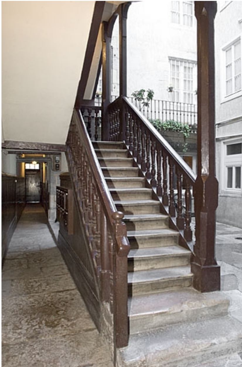
Vue du départ de l'escalier à cage ouverte depuis le couloir.
