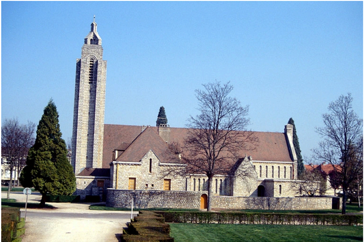
Façade latérale droite.
