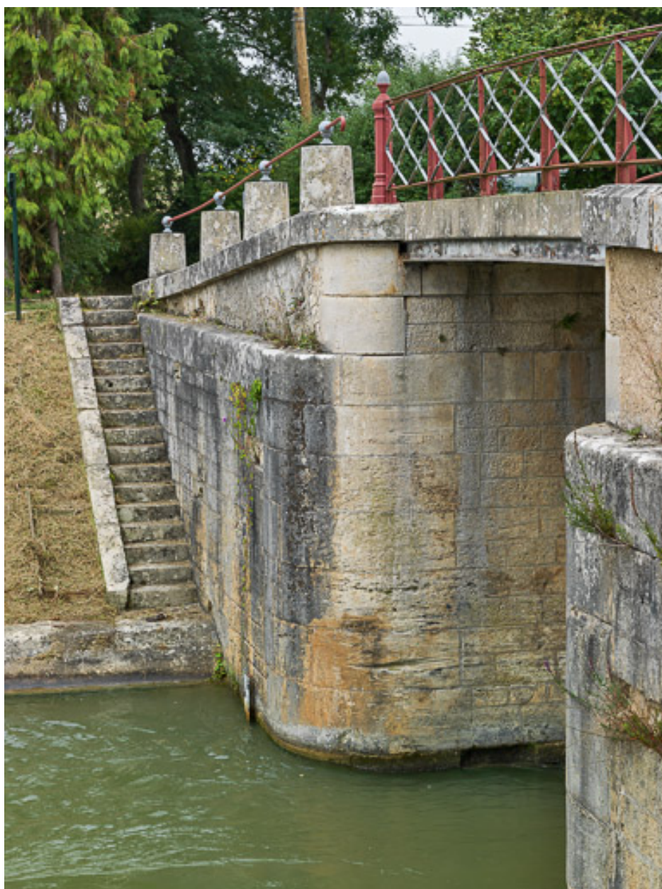
Vue des piles du pont.
