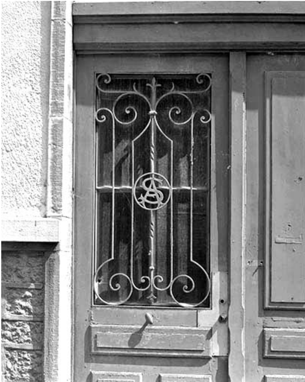
Ferronnerie d'une porte des bureaux (extrémité occidentale).
