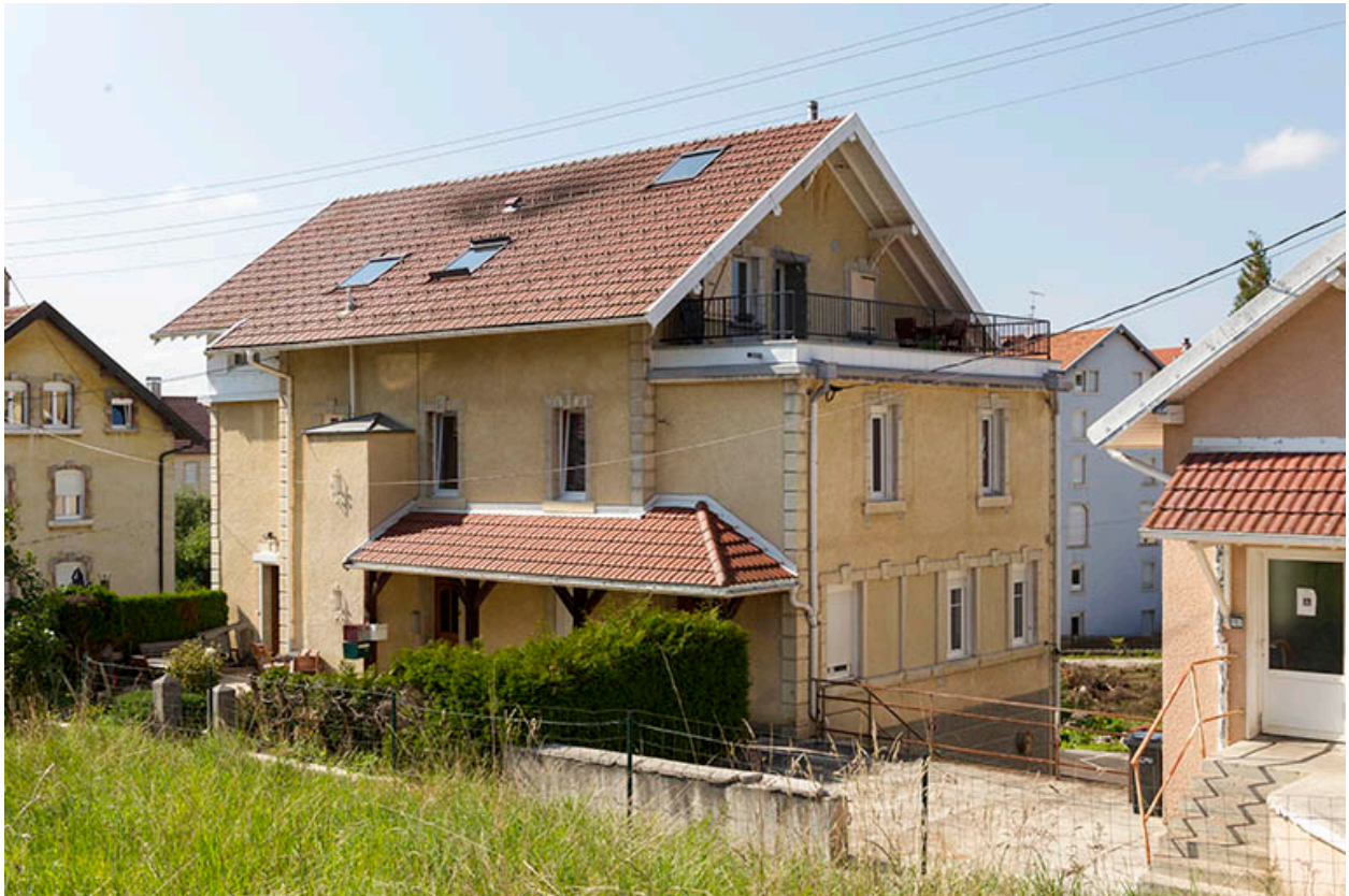
Maison : façades antérieure et latérale droite.
