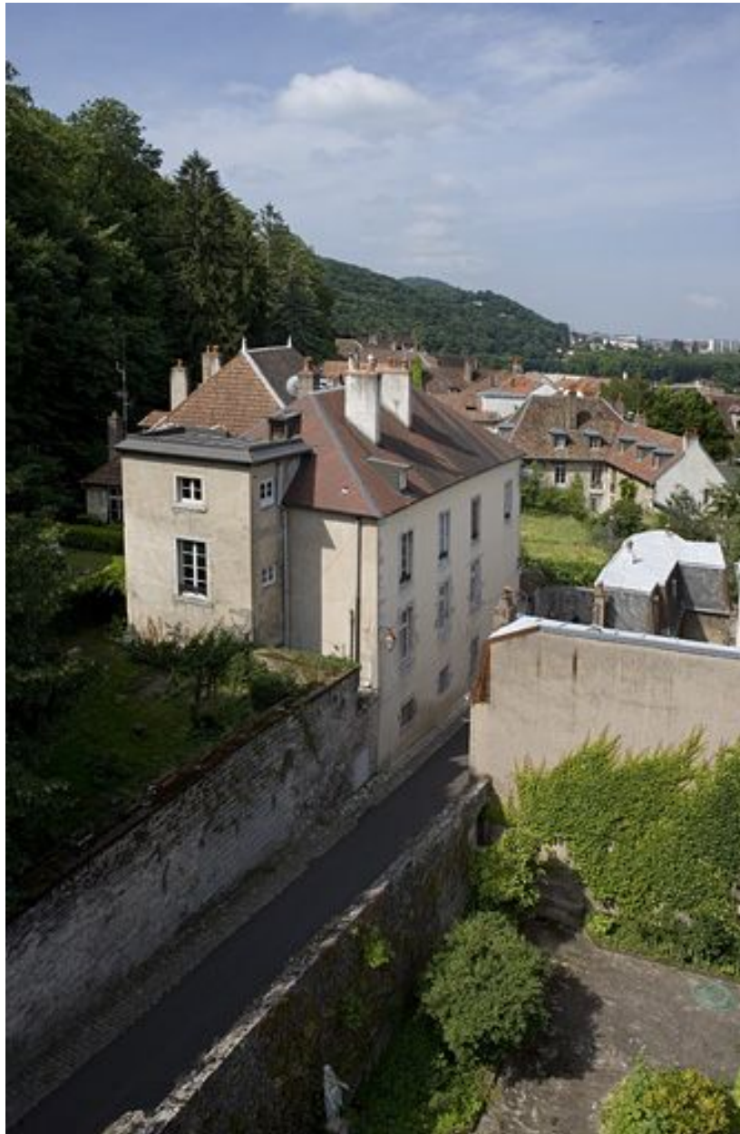
Vue d'ensemble depuis les locaux du CRDP.
