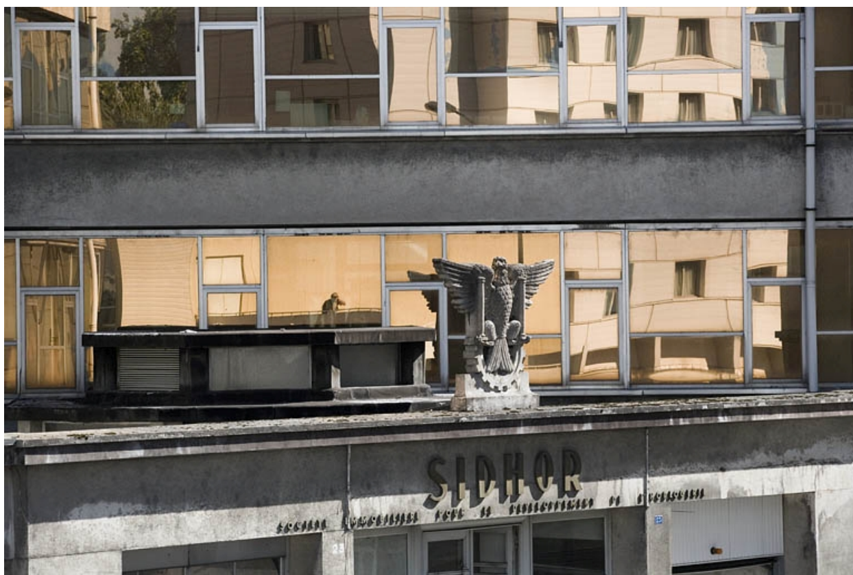
Détail de la façade, vue de trois quarts gauche.
