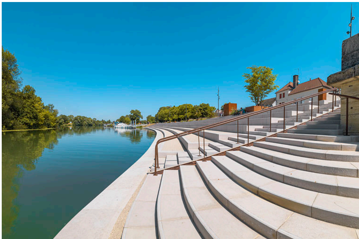
Vue d'ensemble des quais après leur réaménagement.
