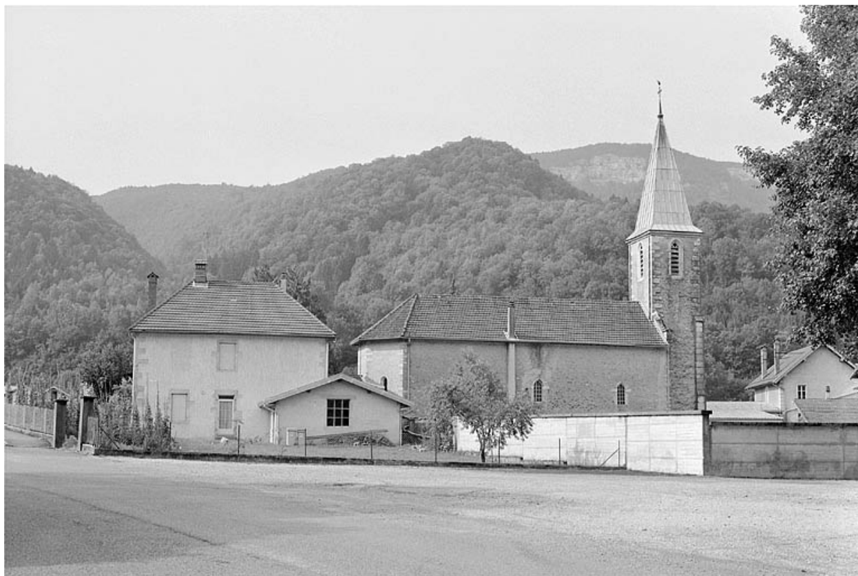
Vue de situation depuis le nord-est.
