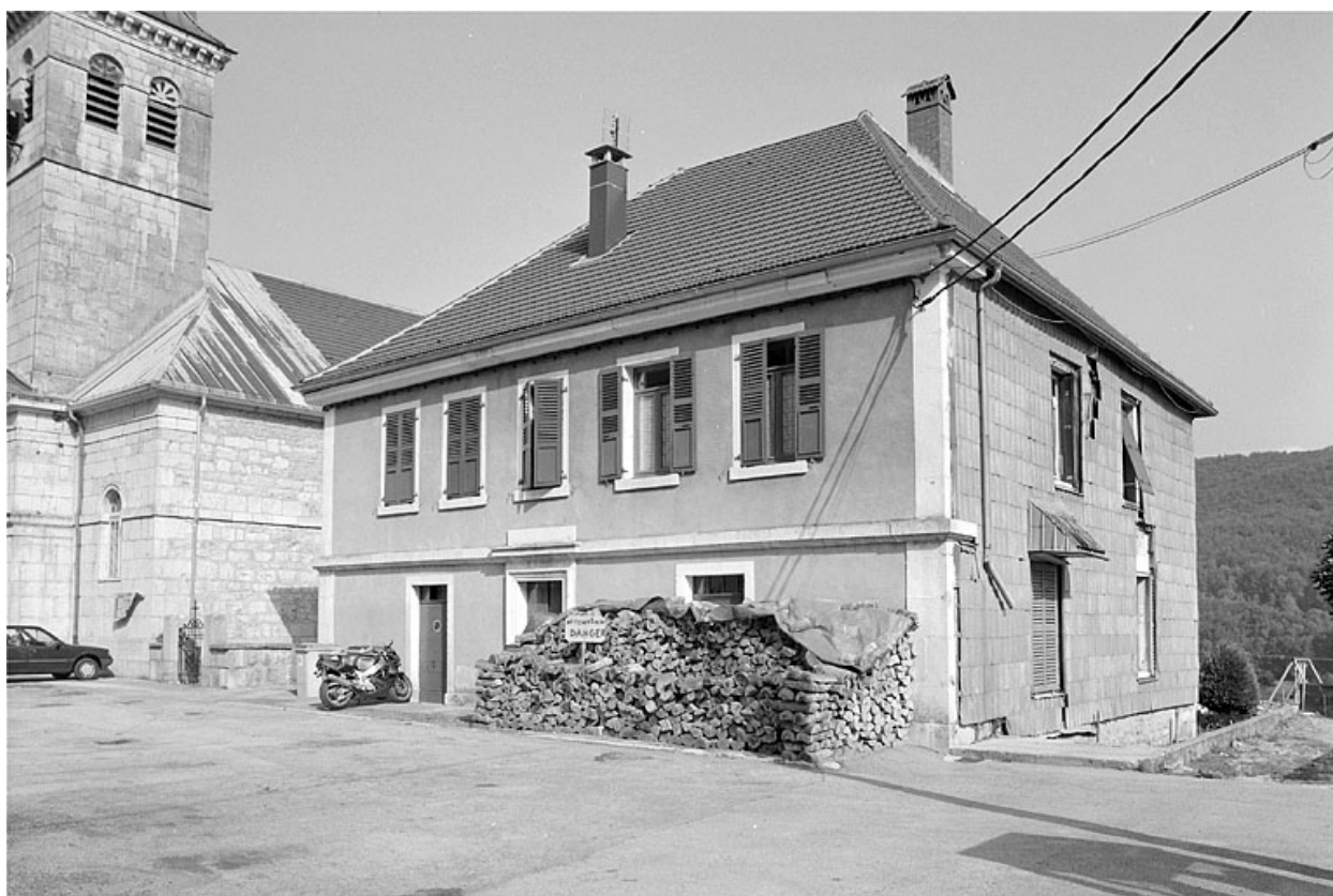
Vue générale depuis la place de l'Eglise.
