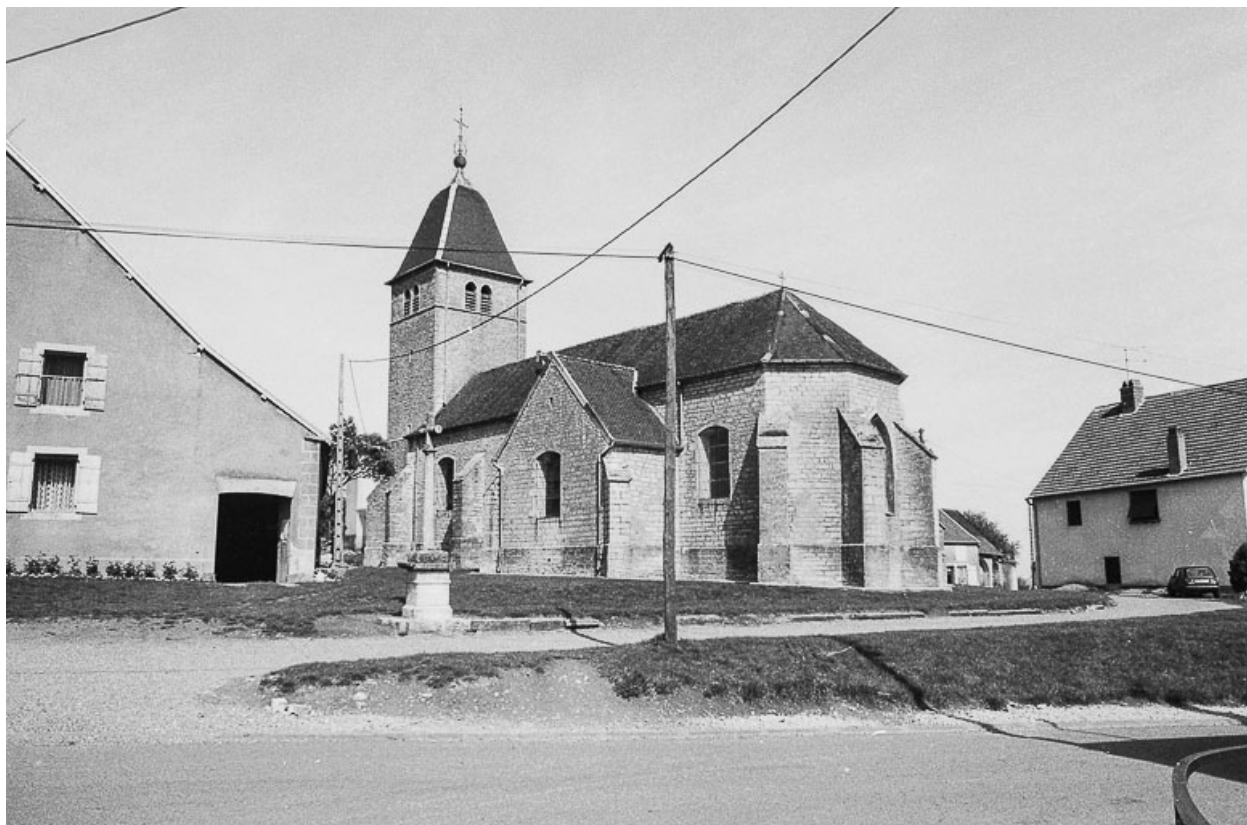
Façade latérale droite.
