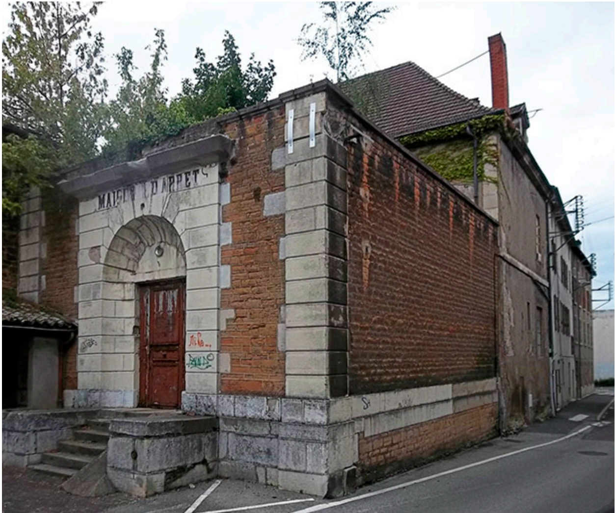
Entrée de la cour de la prison depuis la rue.
