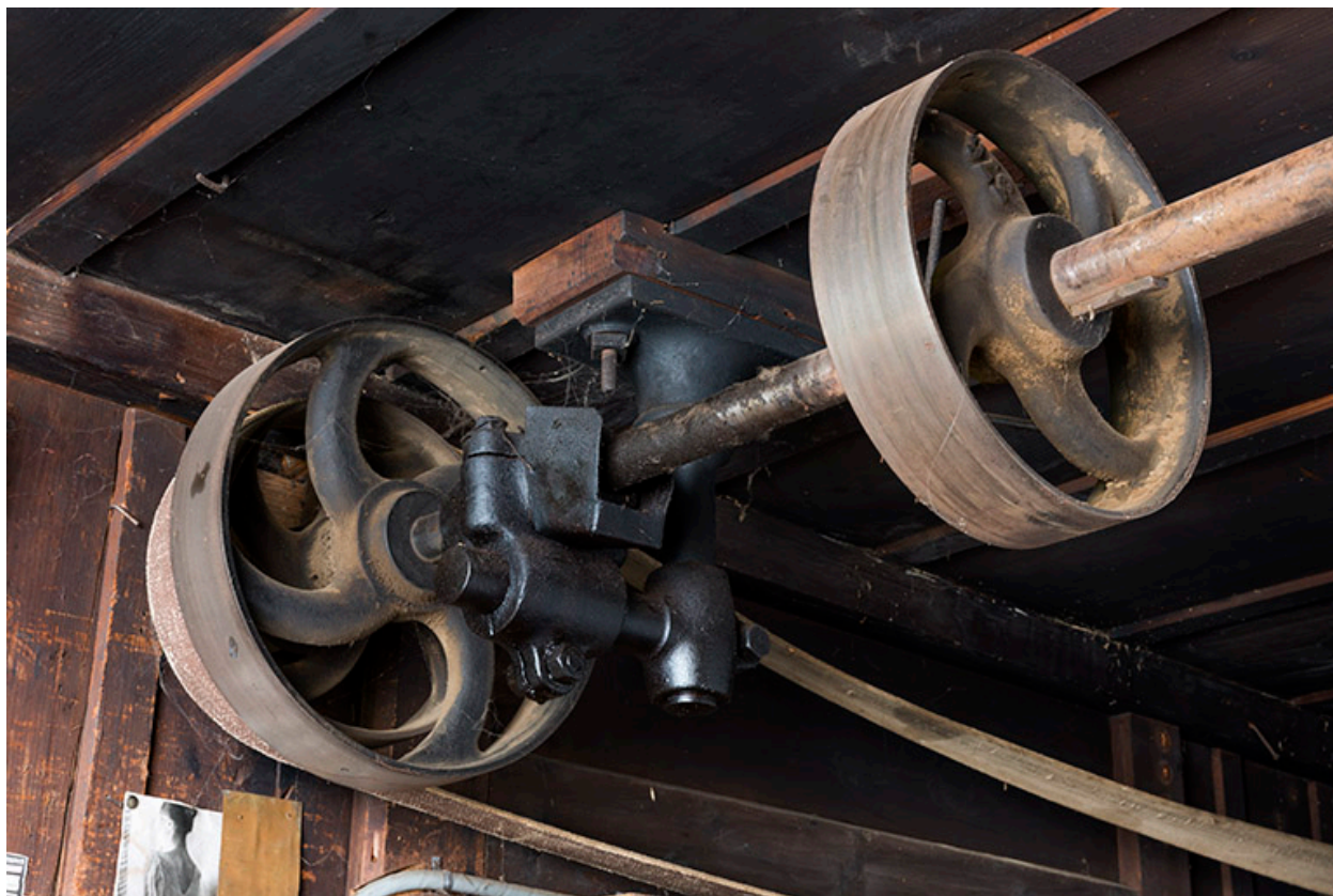
Atelier : transmission au plafond.
