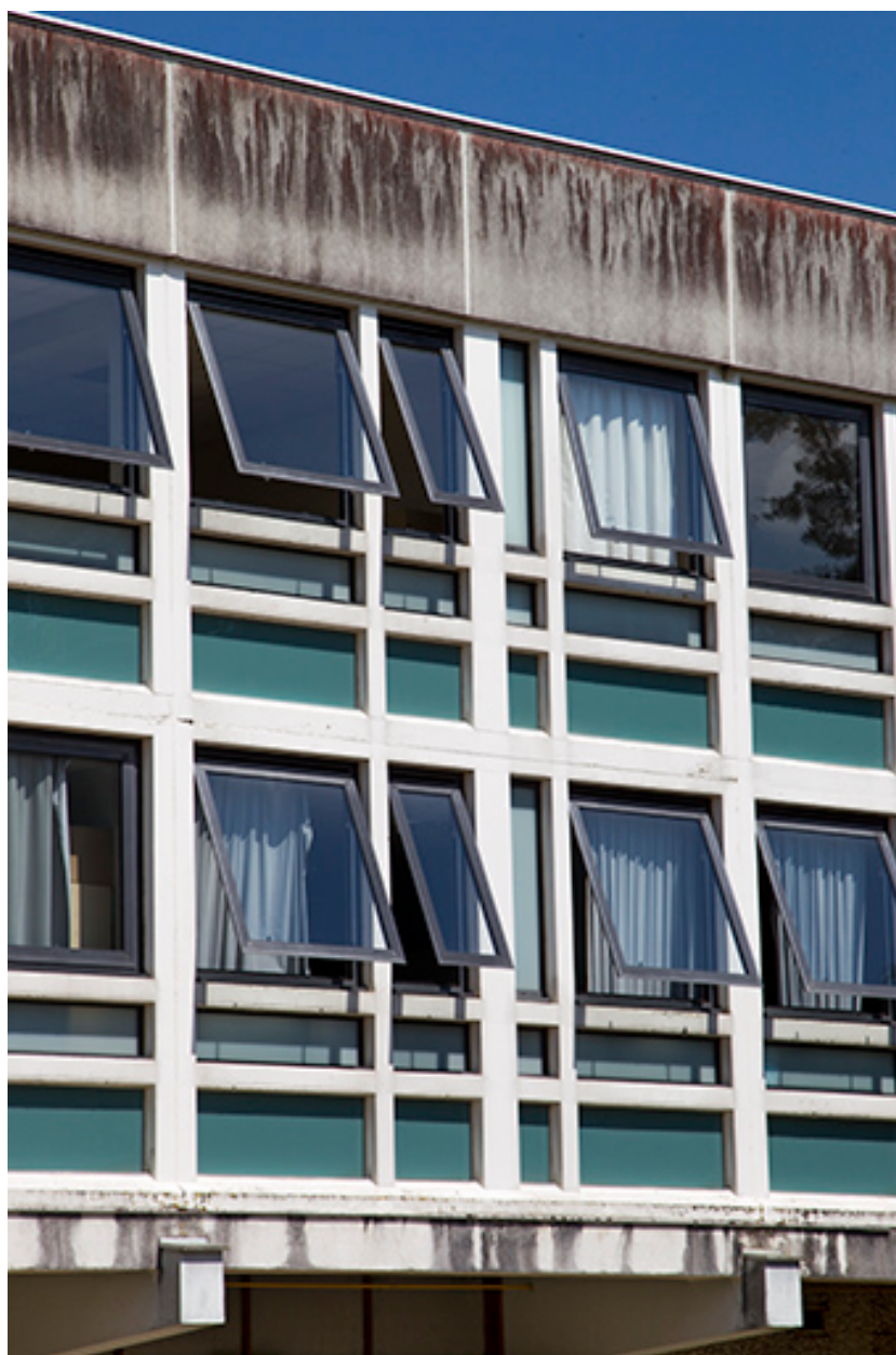
Détail de façade postérieure - ouest - de l'externat.
