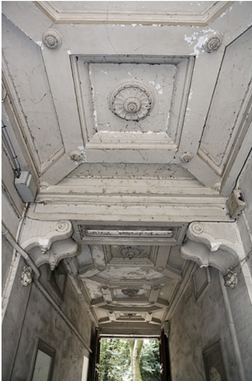
Détail du plafond du passage cocher : vue rapprochée.
