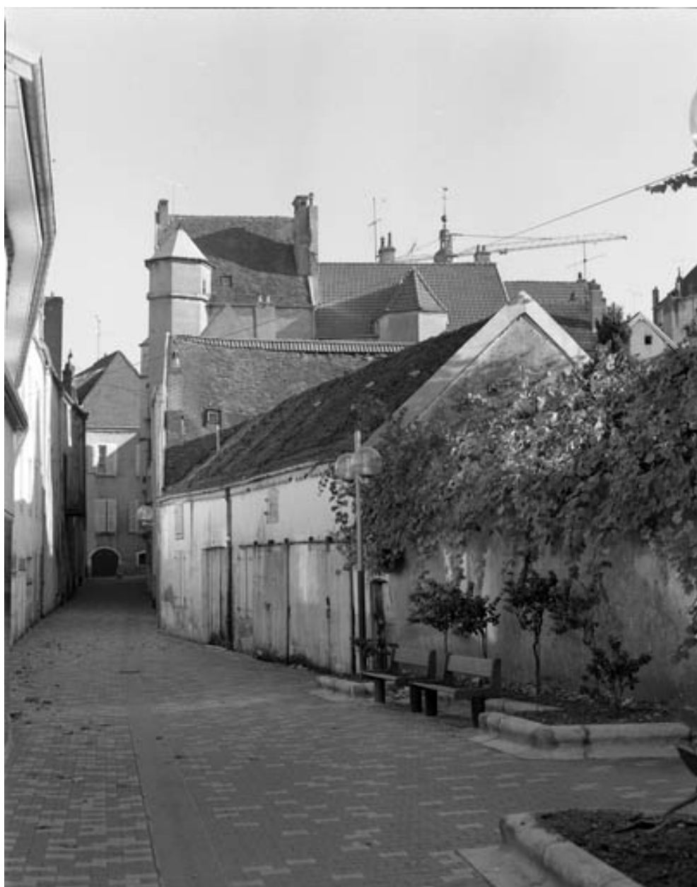
Façade postérieure depuis la rue de l'Abreuvoir.
