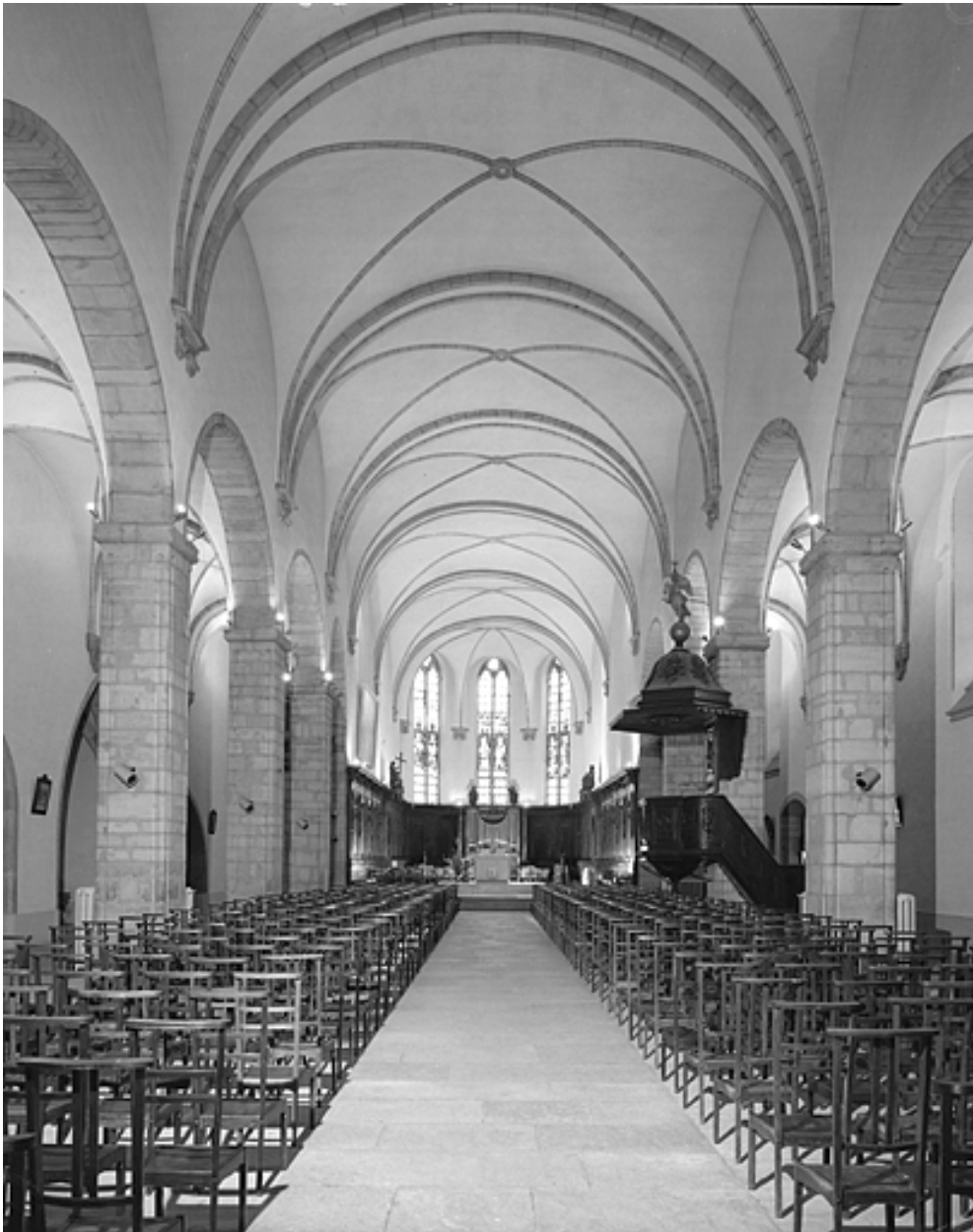
Eglise, vaisseau central, vue générale depuis l'ouest.
