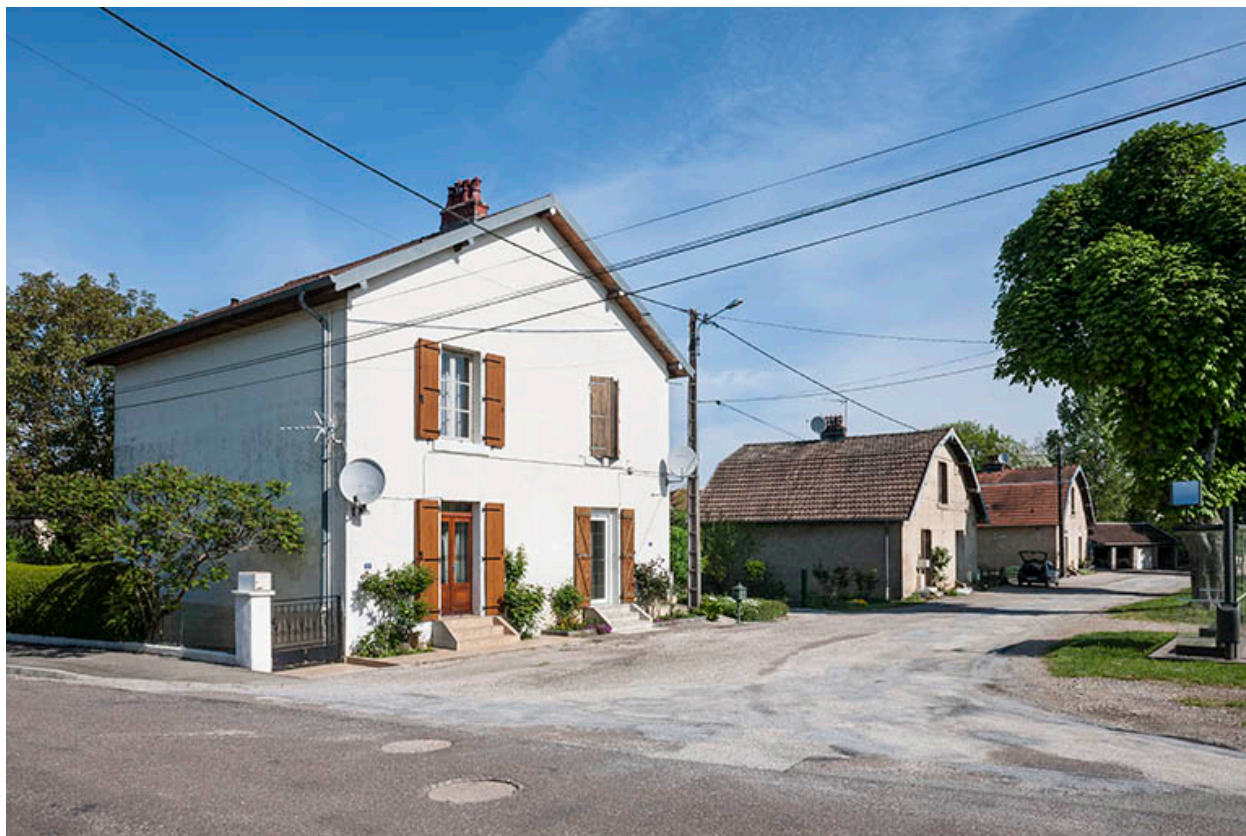
Logements ouvriers (4 à 10 allée des Rompeux).
