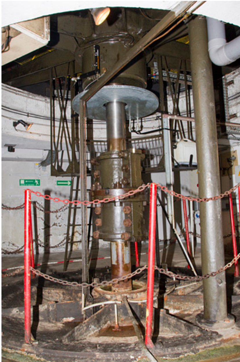
Détail de la transmission verticale d'une turbine.
