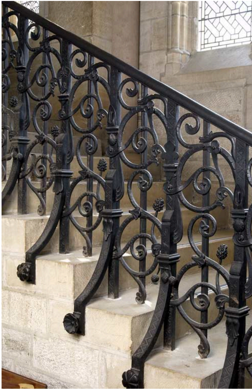
Bâtiment du réfectoire : partie sud du bâtiment (aménagement néo-gothique) : escalier, rampe d'appui en fer forgé, exécutée par Alexandre Chaussonot.
