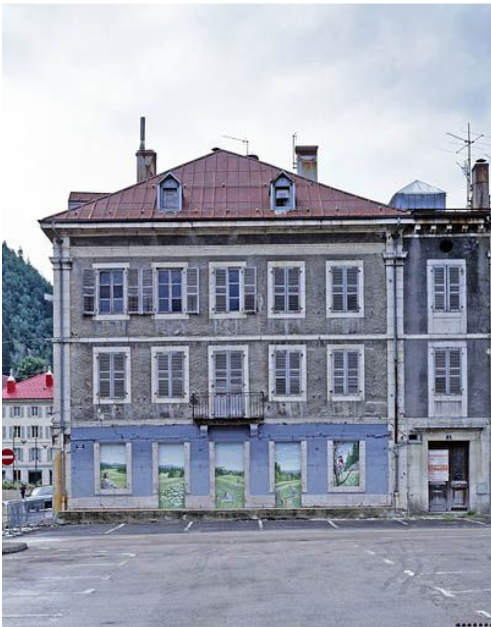
Le corps de bâtiment oriental.
