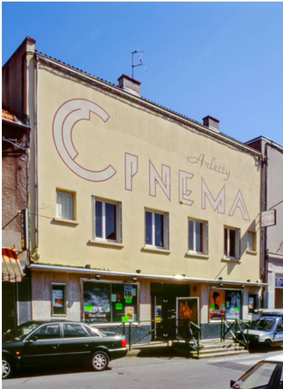
Façade antérieure de trois quarts gauche, en 2001.
