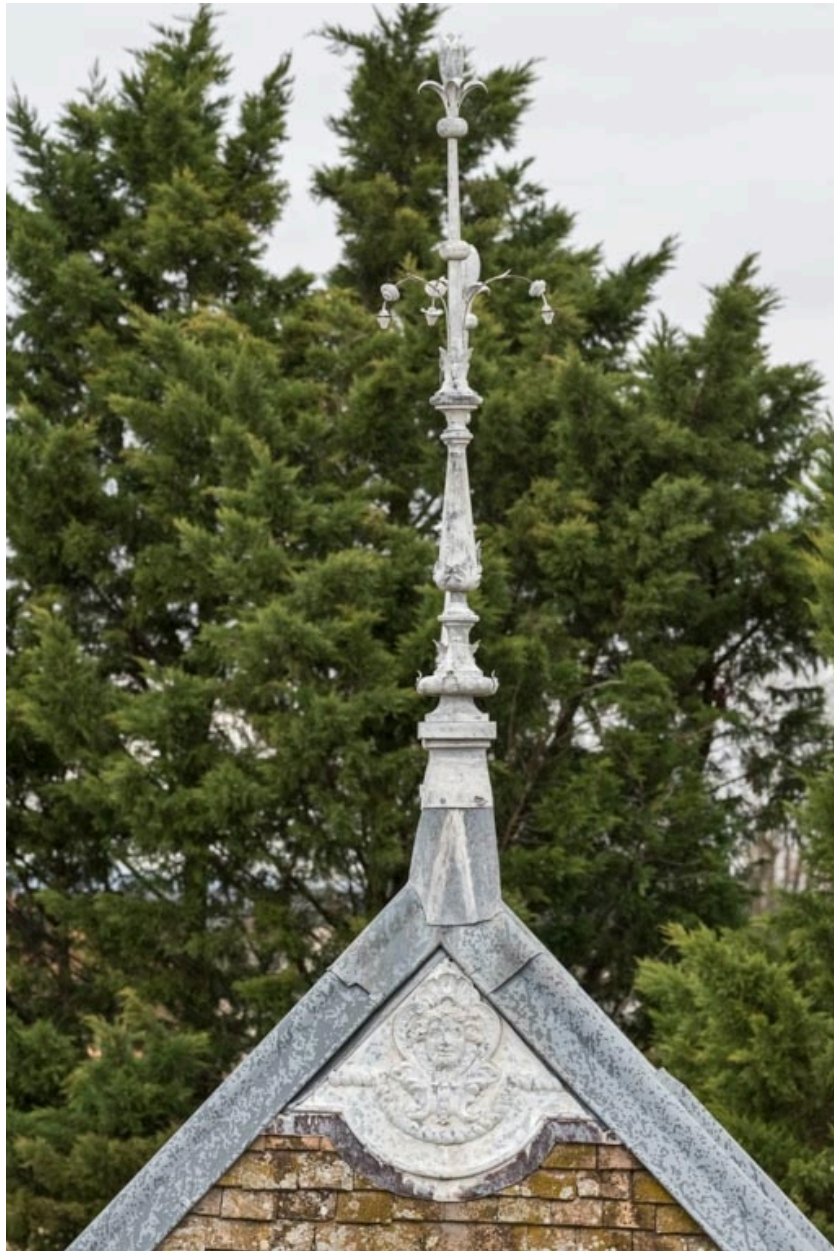
Epis de faîtage sur le corps nord.
