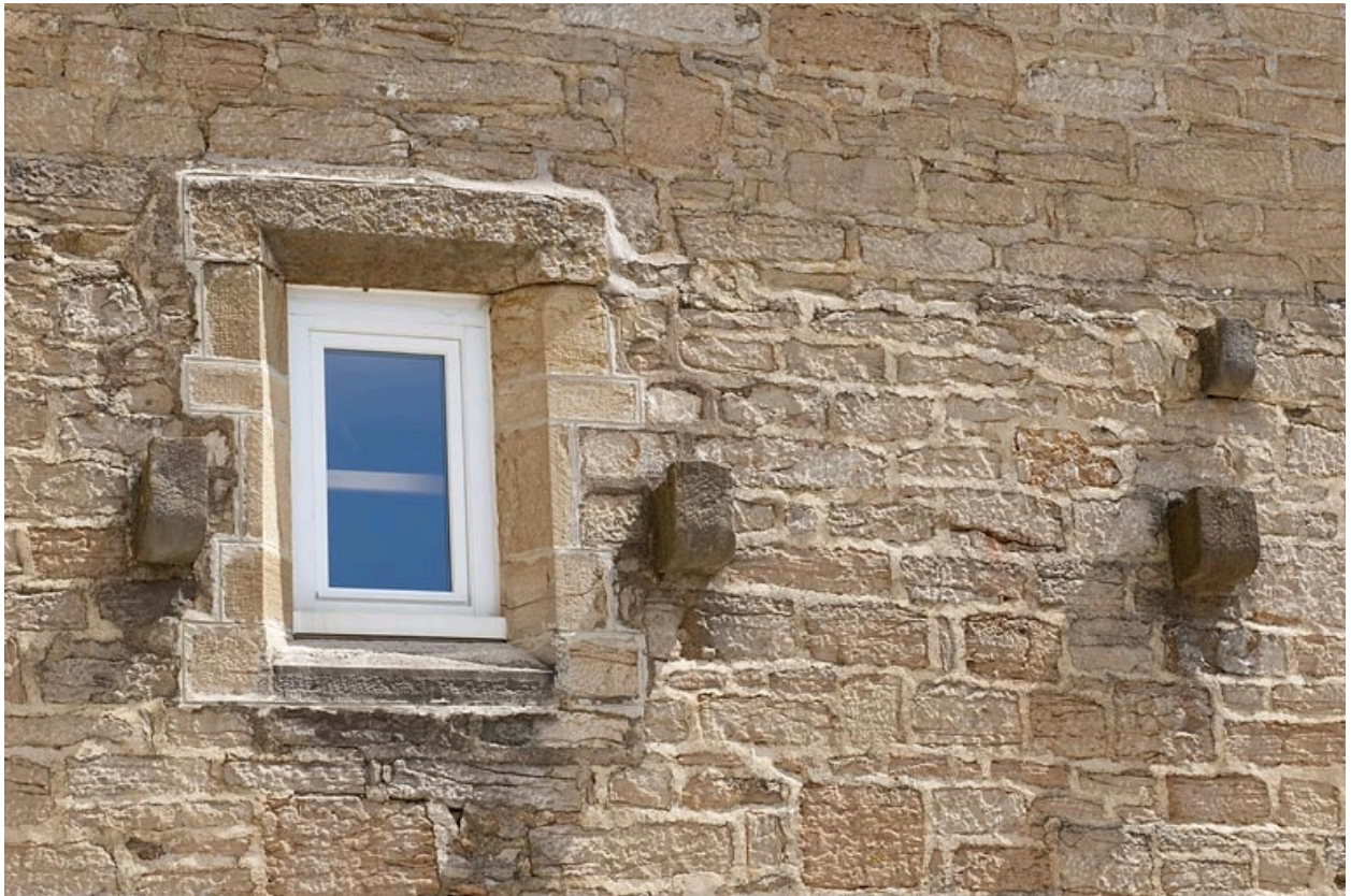
Chapelle (D), vue d'une baie.
