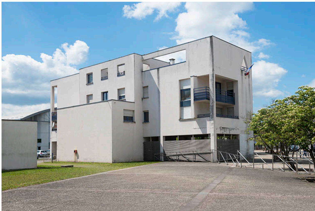
Angle sud-est des logements ouest.
