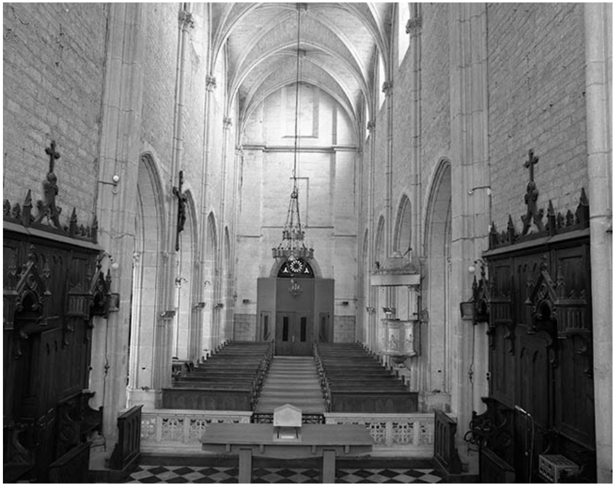
Nef vue depuis le chœur.
