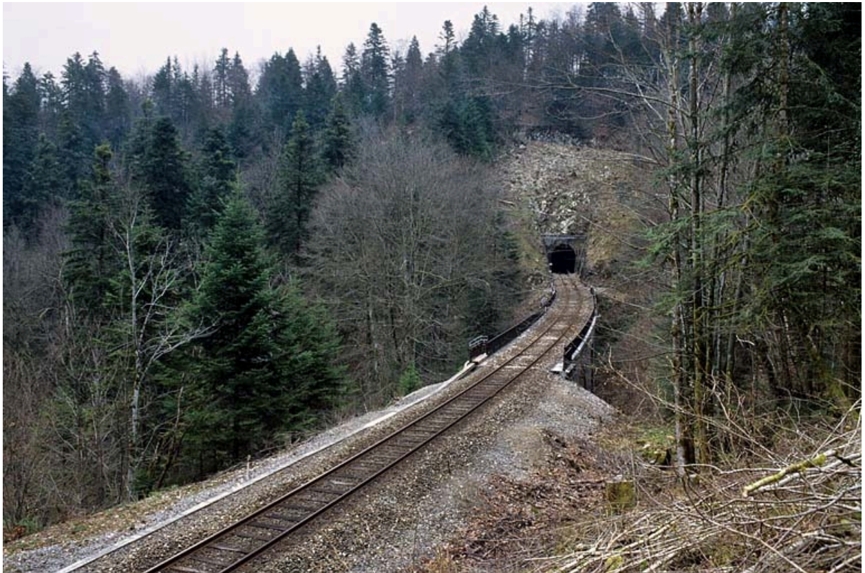
Vue d'ensemble, depuis le nord-ouest (côté Andelot-en-Montagne).
