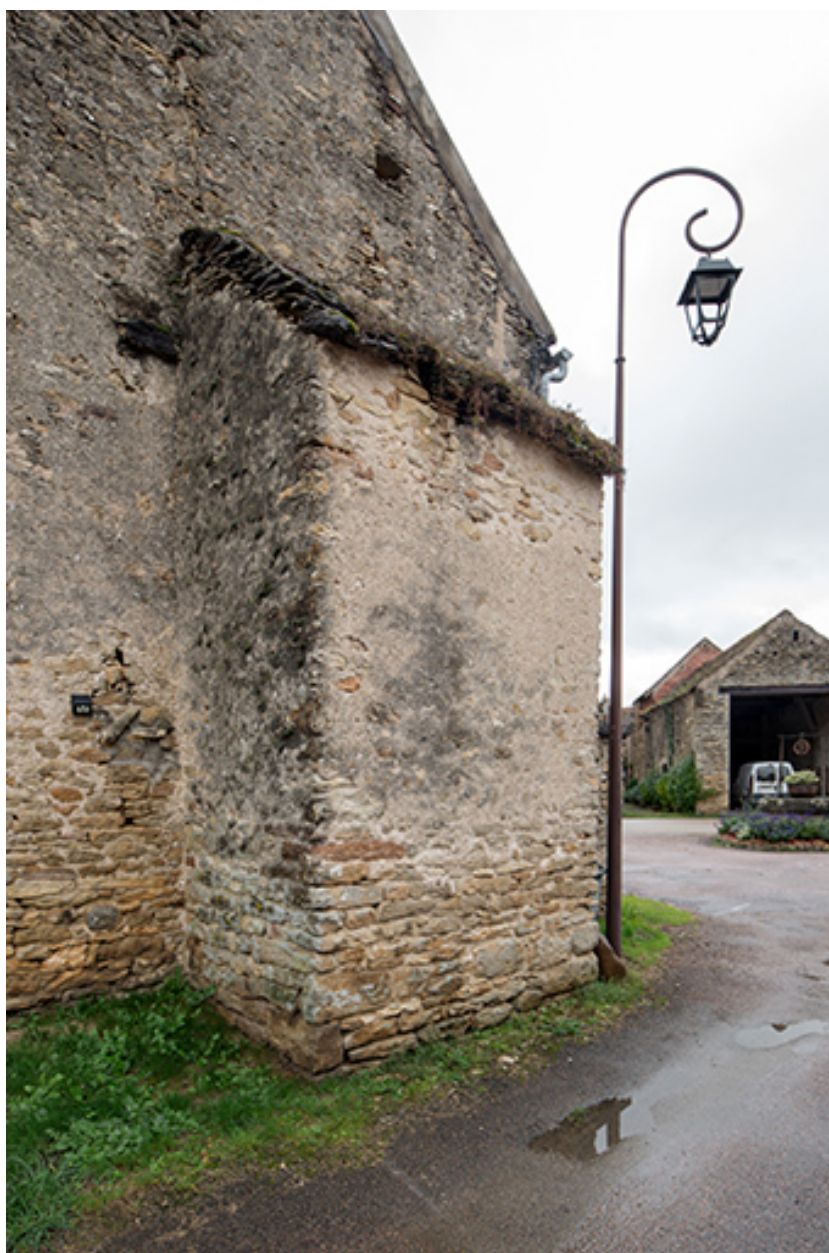
Le four, depuis la rue des Pierres.
