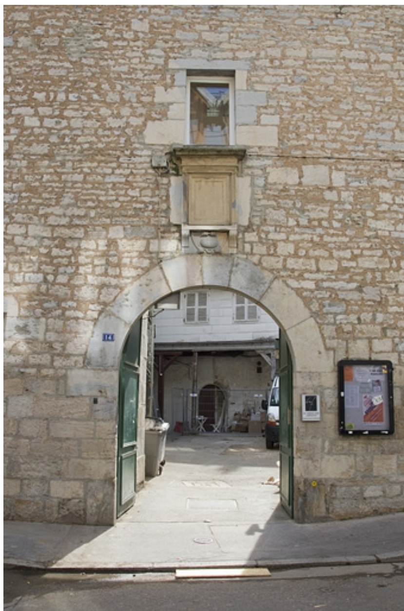
Façade latérale droite : détail du portail d'entrée.
