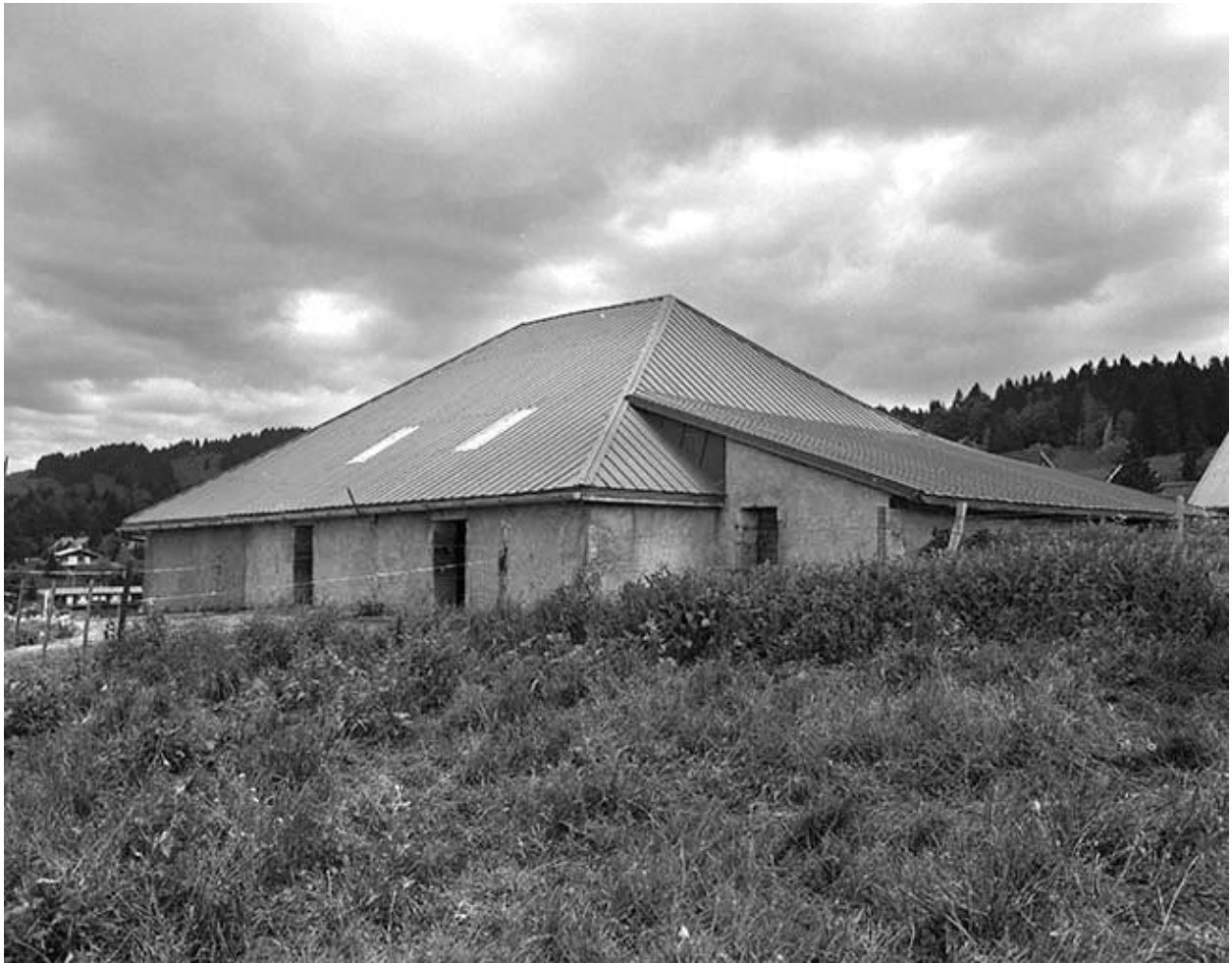
Façade postérieure vue de trois quarts droit.
