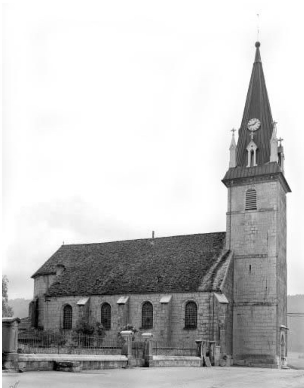
Façade laérale gauche.
