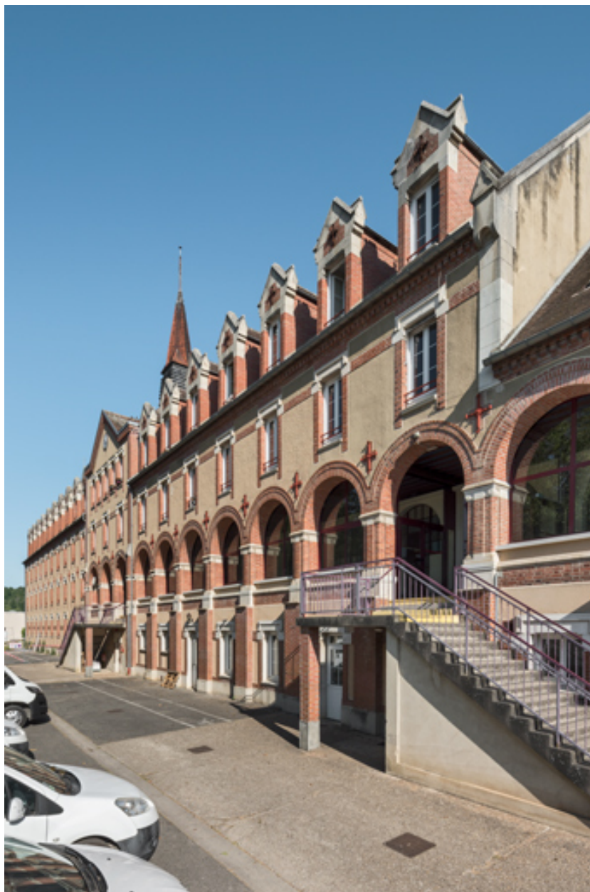
Vue de la façade sud (de trois-quarts).
