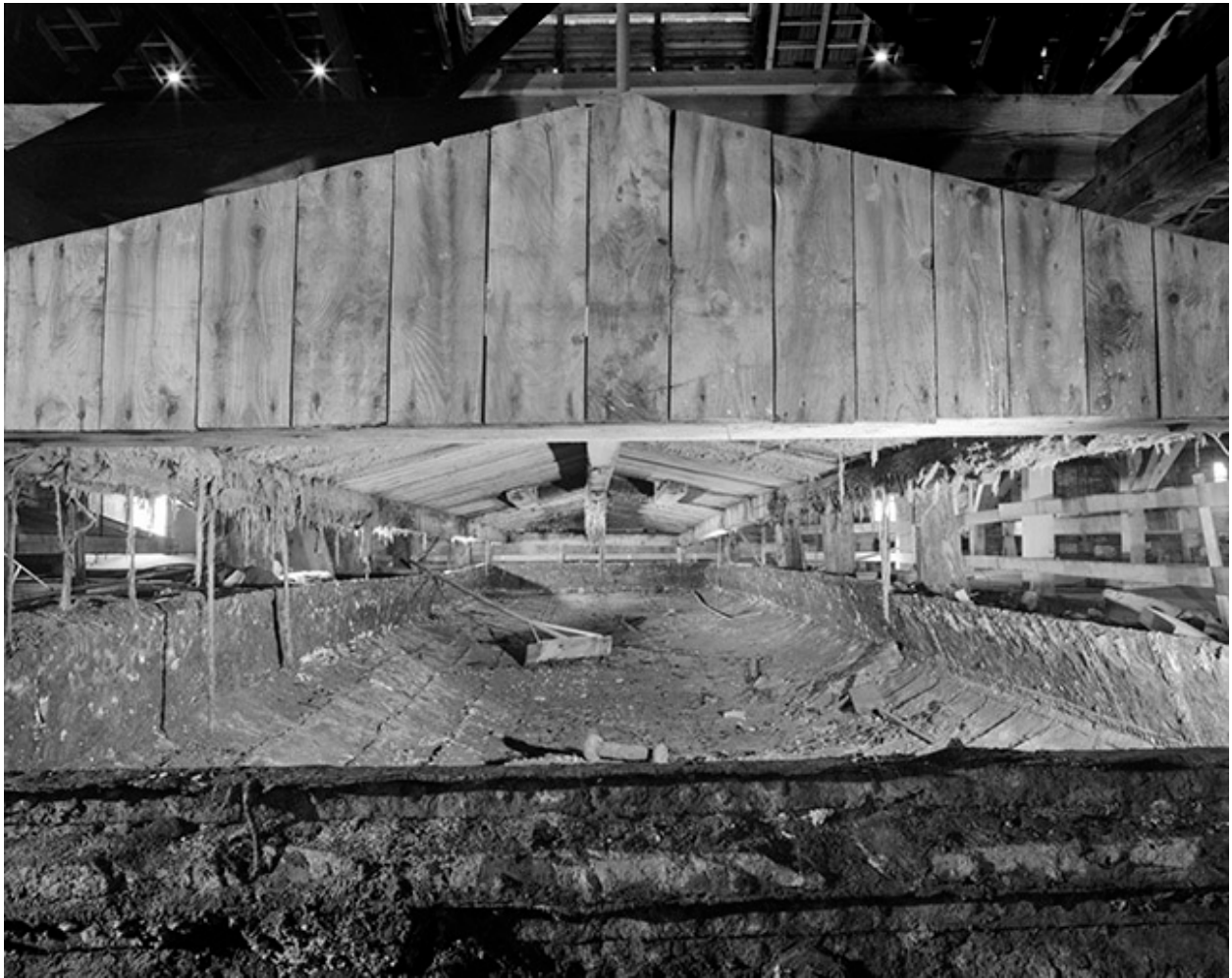
Vue intérieure d'une poêle : tôles rivetées et égouttoir en bois (1993).
